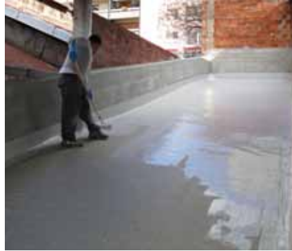
Application de la couche de Triflex Cryl Finition 205 Gris Lumière
