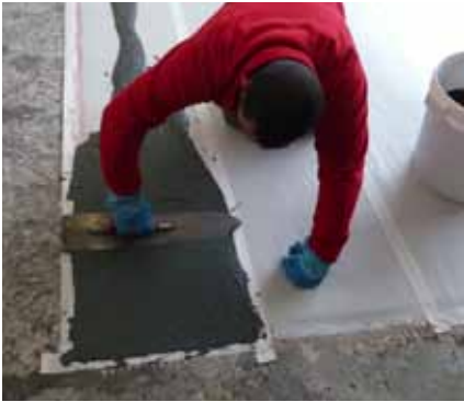
Application de la couche de roulement Triflex Cryl M 264
