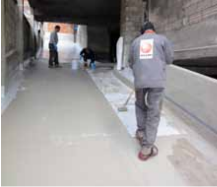
Application de la couche d'étanchéité Triflex ProPark et voile de renfort
