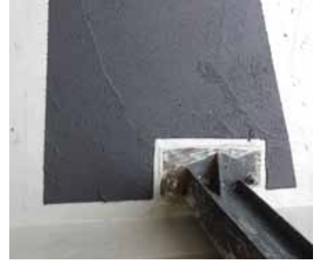
Des détails de surface nets avec la couche de roulement Triflex Cryl M 264
