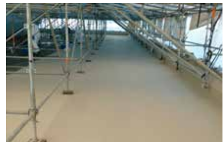
L'étanchéité posée
