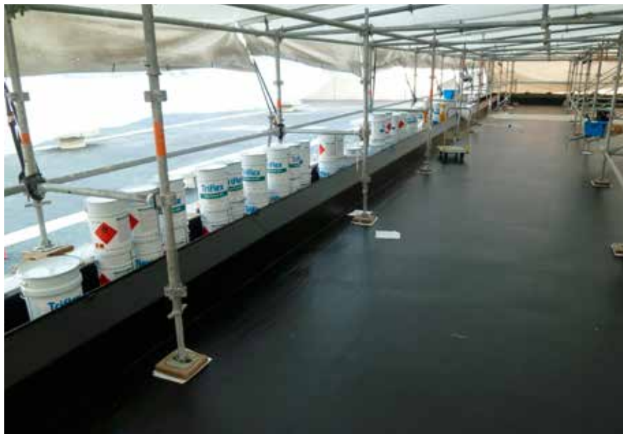
La finition terminée
