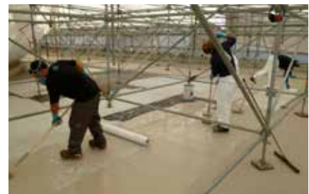
Etanchéité horizontale
