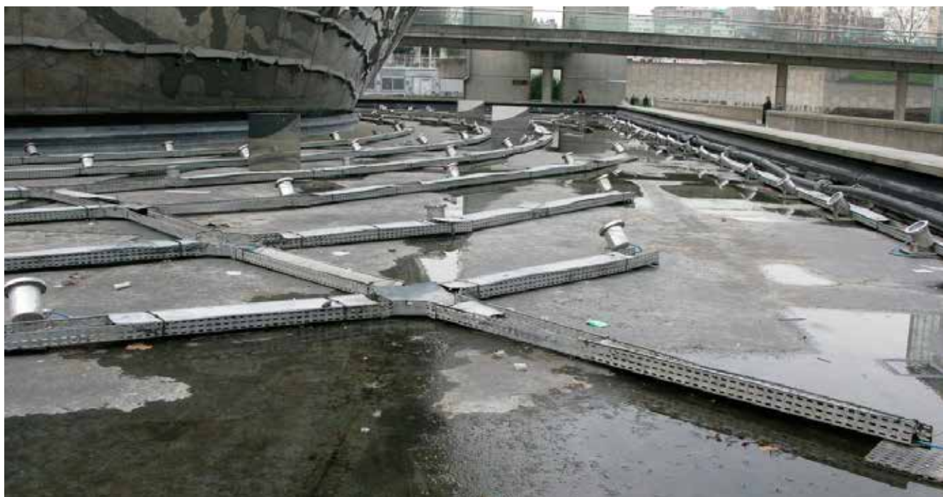
Avant les travaux
