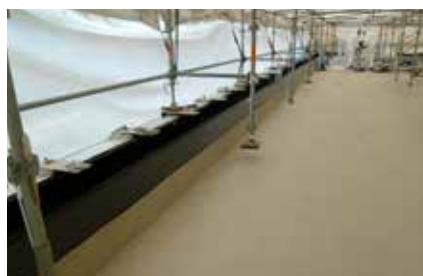
Pose de la finition
